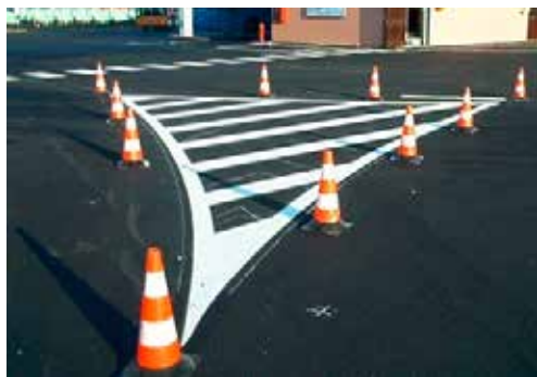
REALIZZAZIONE SEGNALETICA STRADALE E SEGNALETICA INTERNA
