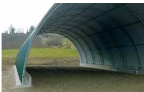
HANGAR PER RIMESSAGGIO AUTOMEZZI O FORAGGI
